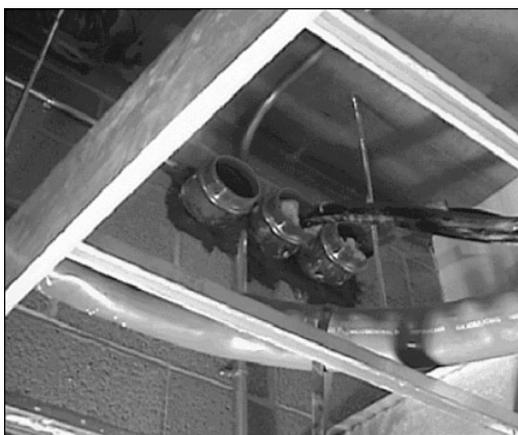
Рис. А.36. Типичные отверстия в противопожарной перегородке
